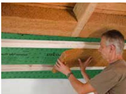
Die Luftdichtheits- und Dampfbremsebene ist gut und flächig herstellbar.
