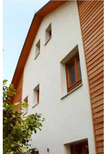
Ob Putzfassade mit STEICOprotect oder hinterlüftete Fassade – mit der STEICO Systemlösung haben Sie die freie Wahl.
