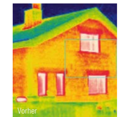
Sichtbare Energieverschwendung einer ungenügend gedämmten Fassade
