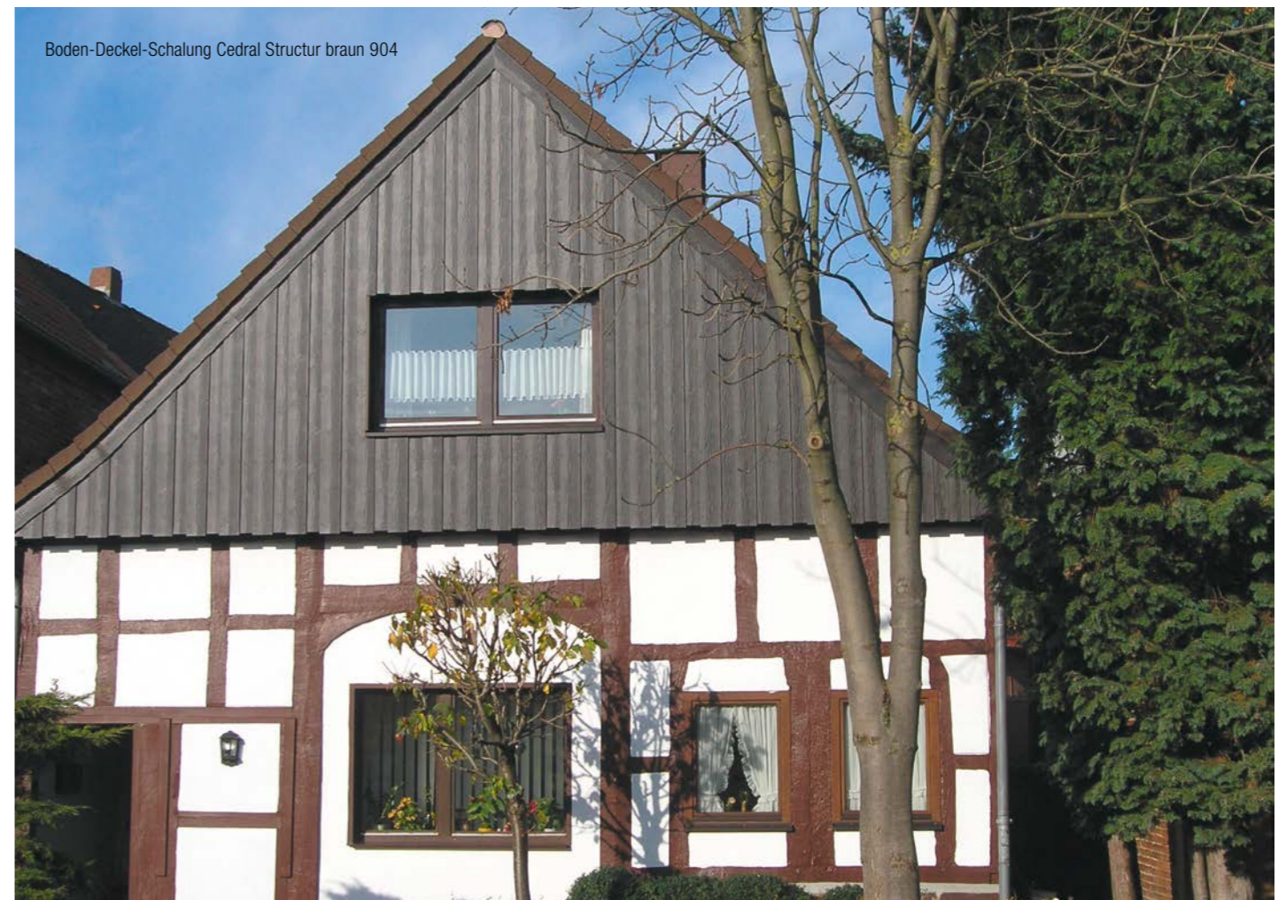
Boden-Deckel-Schalung mit Cedral Structur
