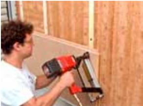
STEICO<sup>protect</sup> Dämmplatten werden auf einer Holz-Unterkonstruktion angebracht. Damit sind - gerade bei der Sanierung von Mauerwerkswänden - viele Vorteile verbunden.
