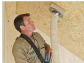
Die Einblasdämmungen STEICO<sup>zell</sup> und STEICO<sup>floc</sup> sind ideale und ökologische Dämmungen für die Fassadensanierung – und besonders wirtschaftlich. Der Hohlraum zwischen den Putzträger- bzw. OSB-Platten und der Bestandswand wird mit losen Holzfasern oder Zelluloseflocken ausgeblasen. Optimale Dämmwirkung ohne Fugen und Verschnitt – bis in den hintersten Winkel.
